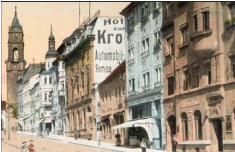
Noch vor der Wende zum 20. Jahrhundert zeigte sich die Steinstraße bereits in der im Wesentlichen heute bekannten Baugestaltung. Nur das Nachbarhaus der Krone war zu diesem Zeitpunkt noch nicht umgebaut.
